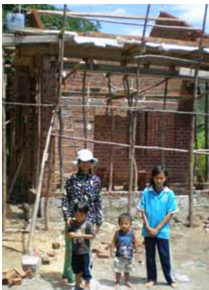
Maison en cours de construction
